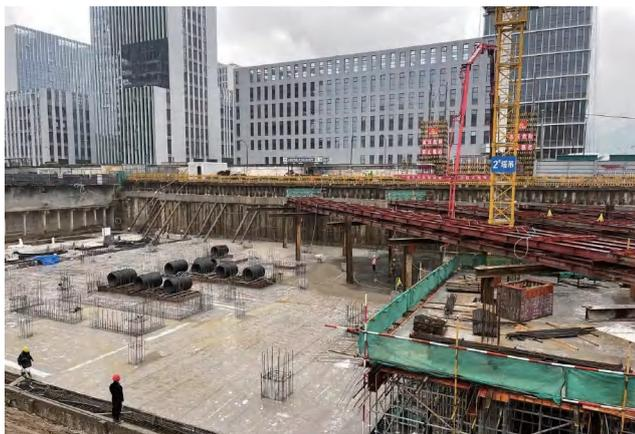
本工程东临集联、连盛项目，且地下室连通，西南北侧为市政道路，基坑支护体系的初步设计方案不符合现场实际情况，考虑到后续工期，建议建设单位多次组织设计方案评审会议，监理部也提出意见及建议，最终评审确定采用：SMW 工法桩 + 注浆钢管前撑，
