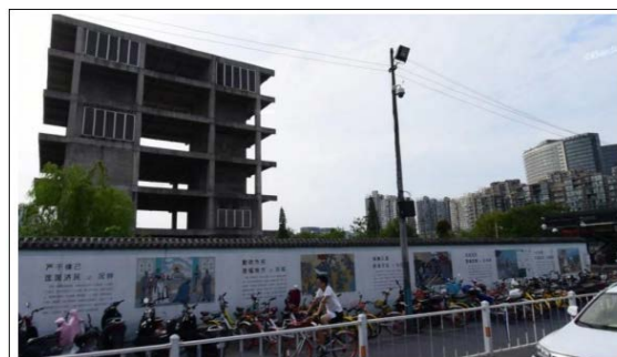
图 1-2 场地东侧地铁 1 号线 2 号出入口及未完工建筑物
