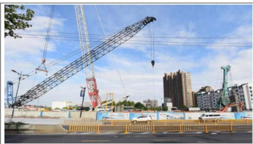
图 1-3 场地东侧地铁 5 号线南北向打铁关站在建项目
