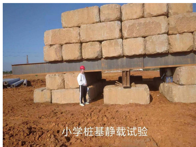
管桩质量检查
